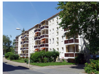
Fahrradständerbau bzw. -einbau – Neue Brücke 3, 11 und 13
